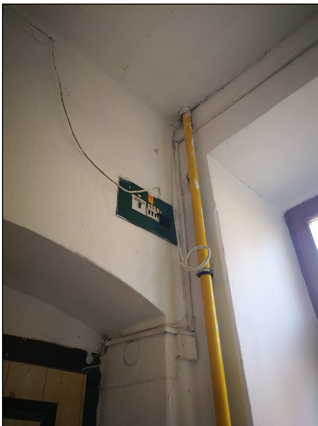
Obr.č. 3 – Stupačka plynu + pojistky elektro
